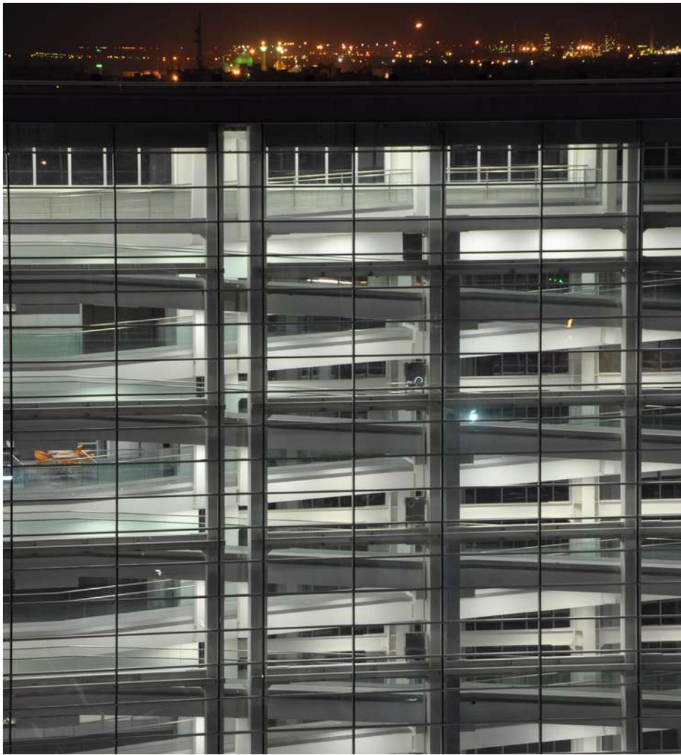
Gambar 2.5.4 Tampak ramp dari luar bangunan Sumber : caoi, 2025
