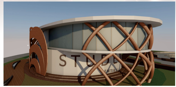
Tiang yang berfungsi sebagai estetika dan menahan beban struktur kolom. MATERIAL ALUMINIUM STAINLESS DIAMETER 30cm
