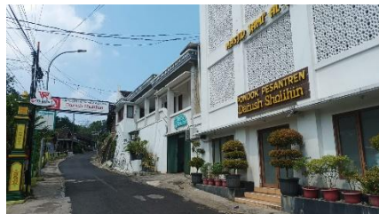
Gambar 11. Masjid Jami' Al-Adha dan Gedung Utama tampak dari luar
