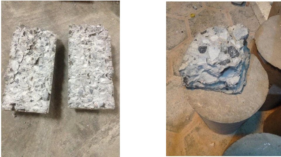
Gambar L-3.3 Beton Normal pengujian kuat tarik belah temperatur 700°C dan explosive spalling 800°C
