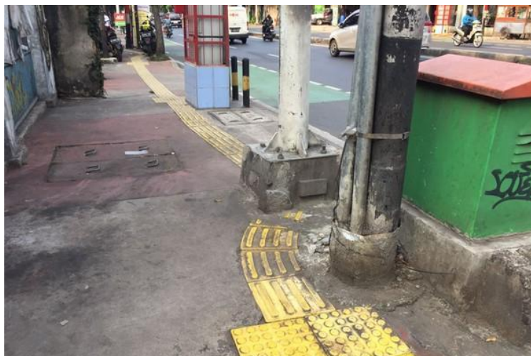
Gambar 2.4. Tata letak guiding block yang salah.
