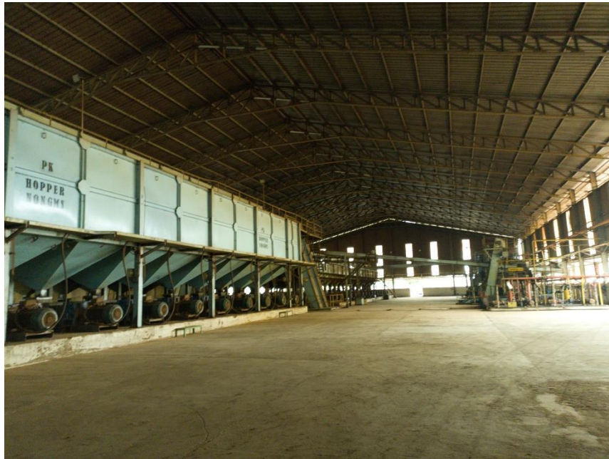
Gambar 8.4.8. Gudang Hopper milik PT. X yang digunakan sebagai Bagian dari Sistem Pengelolaan Rantai Pasok Internal Perusahaan.
