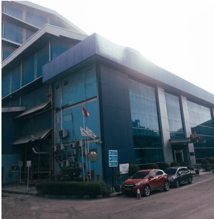
Gambar 1. 4. 1 Gedung PT X
