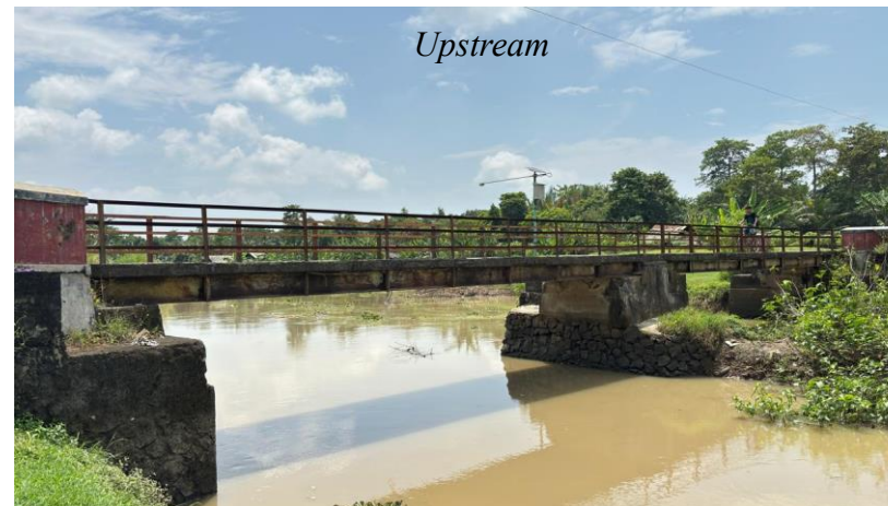
Gambar 5.11 Dokumentasi Lapangan di Titik Jembatan Sta.23,5
