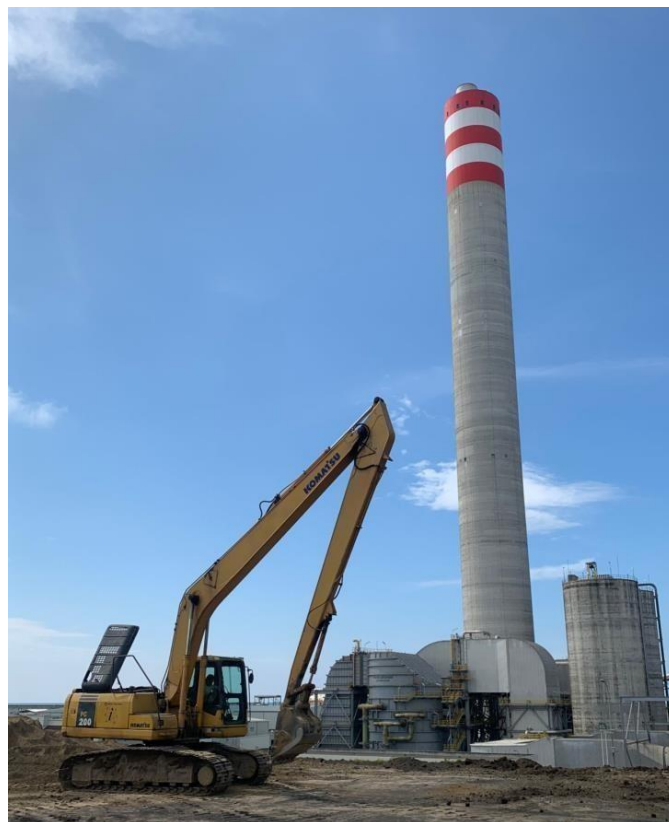
Gambar 4. 1Excavator Komatsu PC – 200 long arm milik PT. Kalinyamat Perkasa
