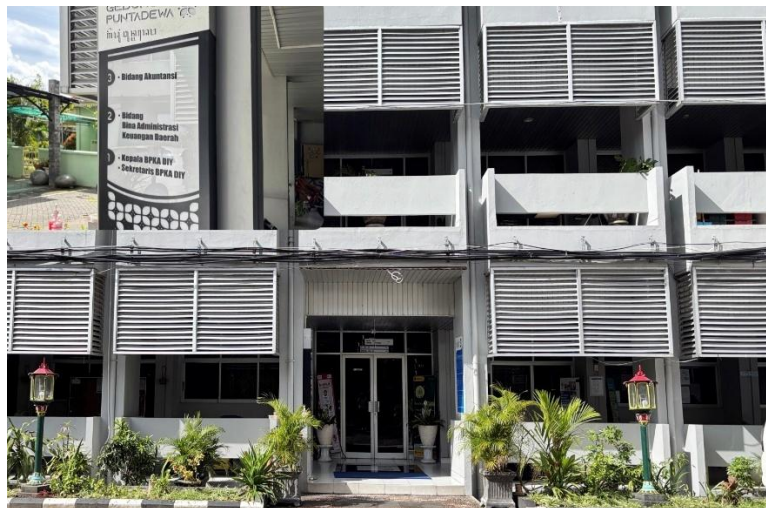
Gambar 4. 1 Gedung BPKA DIY
