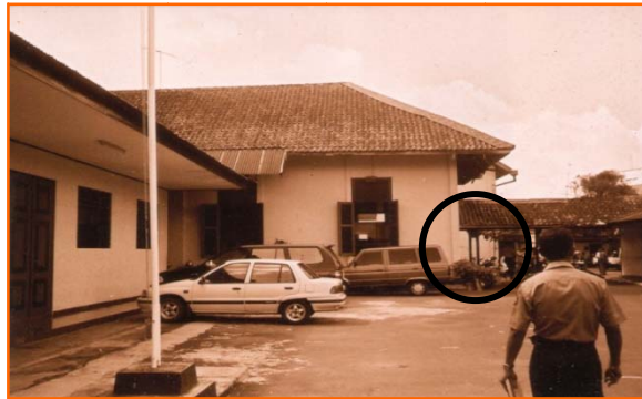
Gambar. 1.7 Penempelan bangunan baru pada ruang asrama Yang pada akhirnya justru menutupi bangunan lamanya
