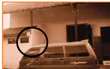
Gambar 1.4 Penambahan fungsi ruang baru (KM/WC) Polres
