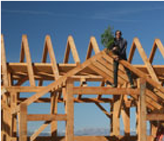
Gambar 3.2. konstruksi yang dikerjakan dengan teknologi setempat Sumber : analisa 2008
