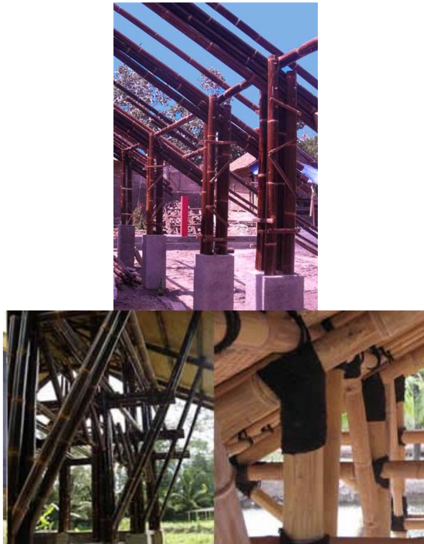
Gb 4.16 Bambu yang digunakan untuk konstruksi
