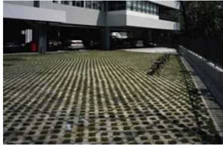
Gb 2.3 perkerasan yang meresapkan air (grasblok)
