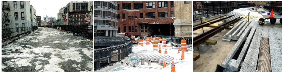
Gb. 2.17. The High Line, New York . Pra-konstruksi. (pembersihan lokasi dari semuanya termasuk rel kereta, setelah bersih diadakan pemasangan paving, serta mengembalikan lagi rel kereta sebagai salah satu elemen taman.)
