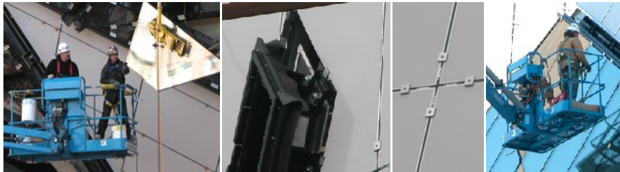
Gb. 3.28. Pemasangan penutup atap Dengan menggunakan bahan metal roof atau bahan transparan.
