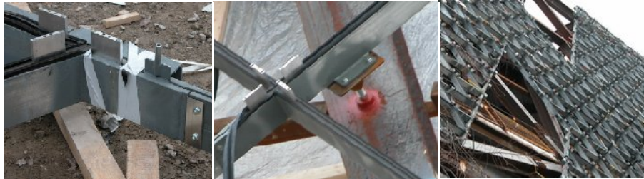
Gb. 3.27. Konstruksi rangka atap
