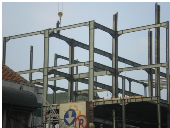
Gambar 4.21. Proses Pemasangan Rangka Baja Pada Bangunan Bertingkat
