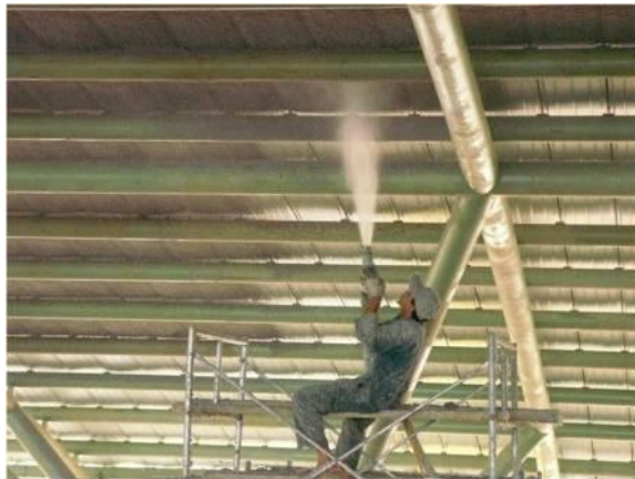
Gambar 4.8. Proses pemasangan Enviro spray pada atap bangunan
