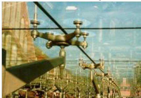
Gambar 2.5. Teknik Spider Pada Proses Pemasangan Kaca
