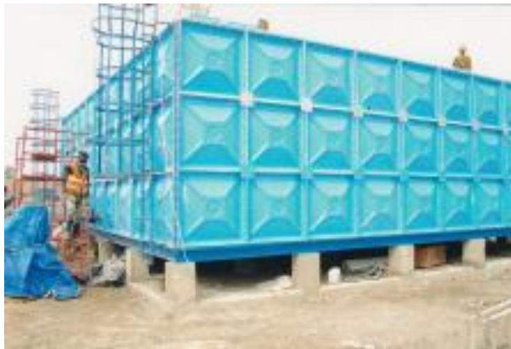
Gambar 4.11. Tangki Penampungan Air sekala besar
