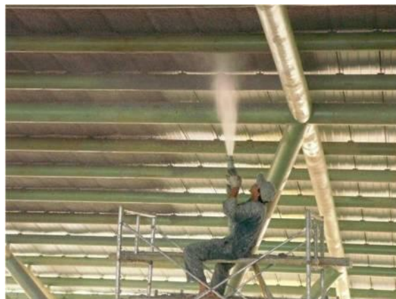
Gambar 3.14. Proses Pemasangan Enviro-spray Pada Bandara Sultan Hassanudin Makasar
