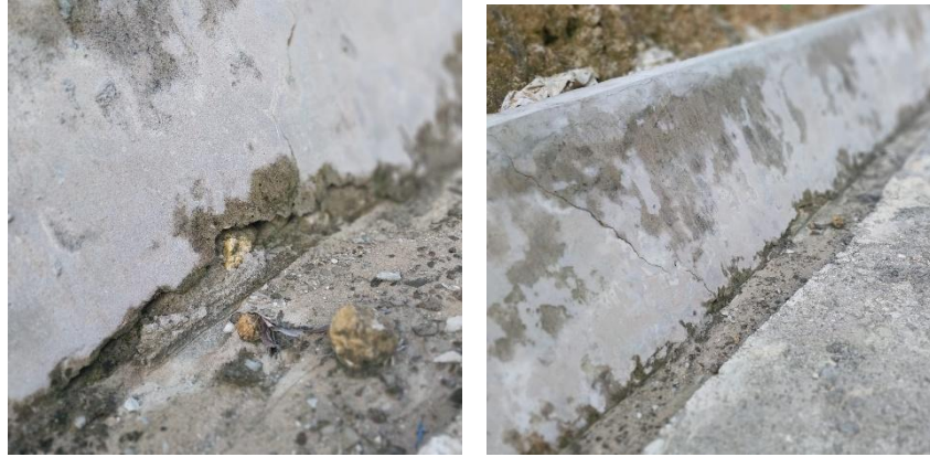
Gambar 5. 3 Kondisi Eksisting Drainase
