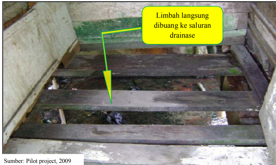
Gambar 4.8 Pembuangan Limbah dari MCK Darurat
