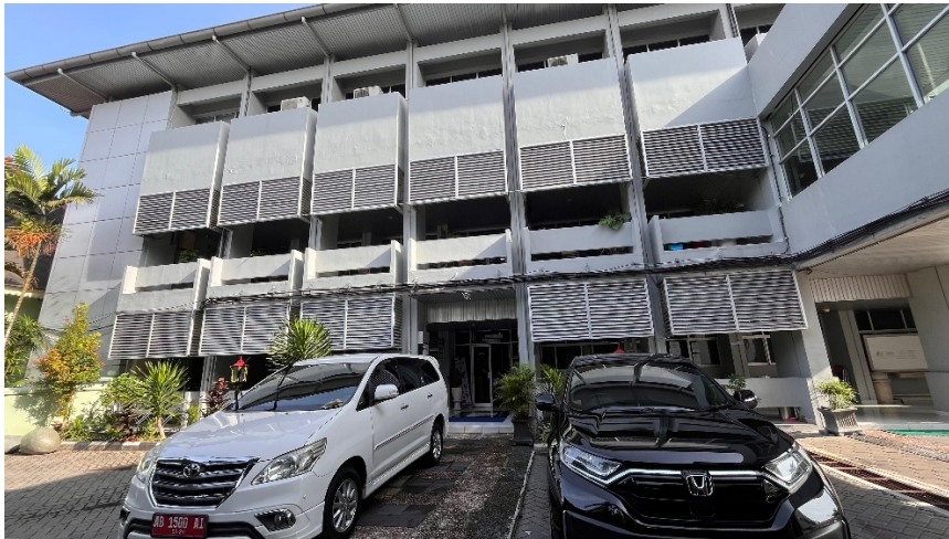
Gambar 4 - Gedung BPKA DIY
