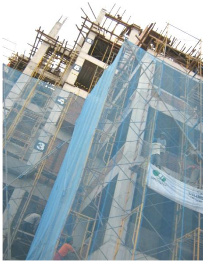
Gambar 5.2 Pekerjaan stuktur atas
