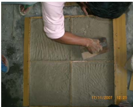
Meratakan Permukaan Plafon
