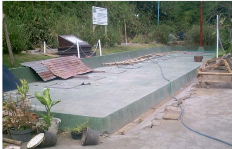
Gambar 2.4 Septictank Komunal warga di daerah Gambiran Baru
