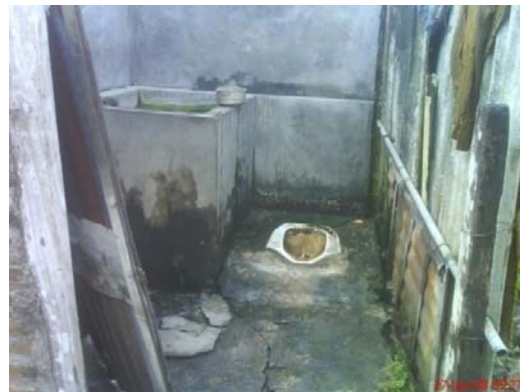
Gambar 5.3 Kondisi MCK umum di Nitiprayan
