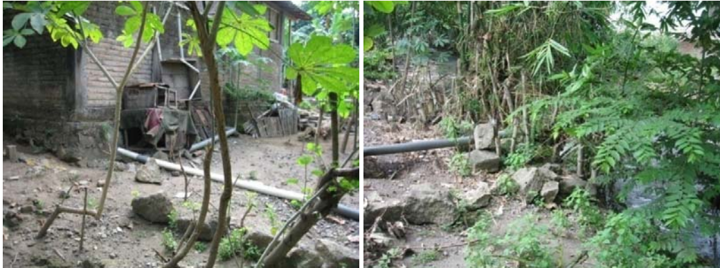
Gambar 5.2 Saluran Pembuangan dari kamar mandi yang dibuang langsung ke Sungai Widuri
