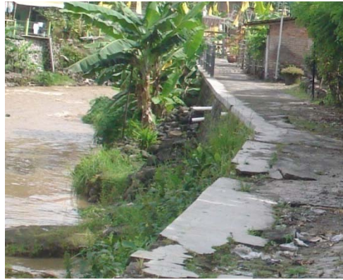
Gambar 4.13 Pipa Saluran Buangan Air hujan dan grey water
