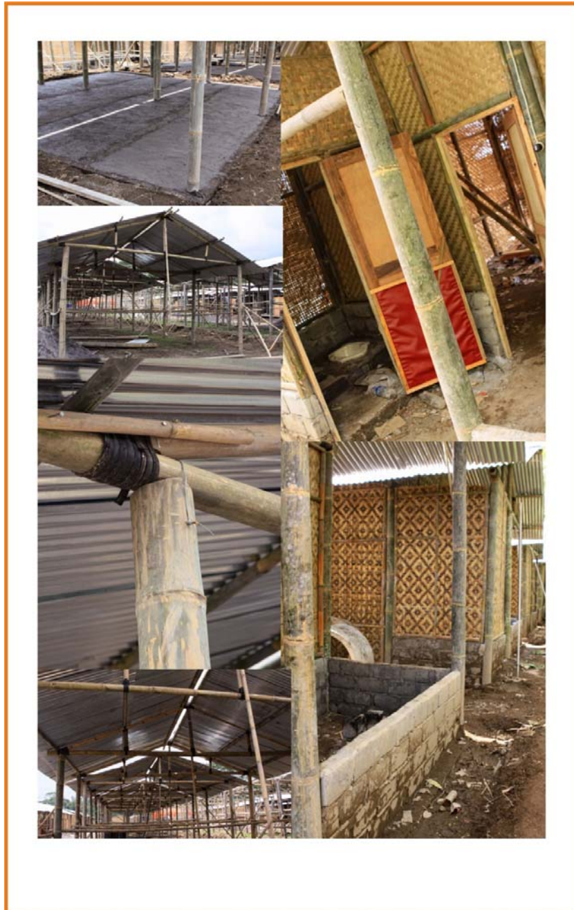
Gambar 3.19 Konstruksi Shelter
