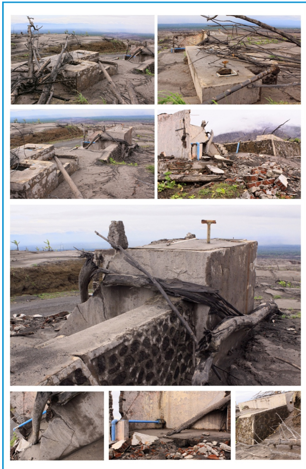
Gambar 3.10 Keadaan Infrastruktur ( bak penampungan air )
