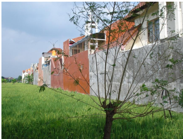
Gambar 15 : Pagar keliling pada permukiman Villa Taman Bunga
