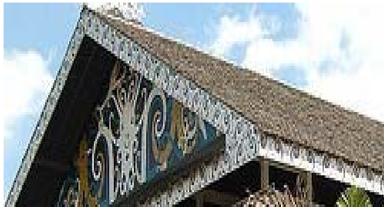
Gambar 2.30 Bentuk Atap Rumah Panjang
