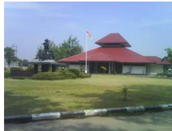
Gambar 4.32. Ruang outdoor sebagai taman
