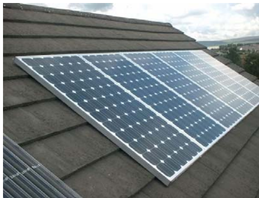
Gambar 2.41 Pemasangan Solar sel pada atap bangunan
