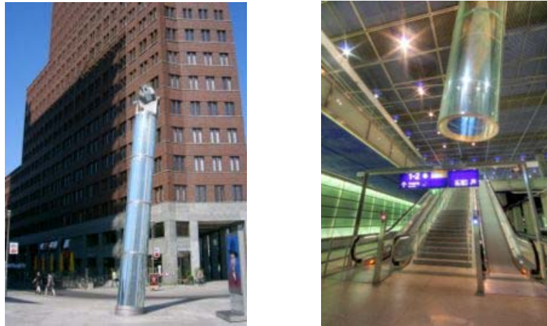
Gambar 2.28 Sunscoop untuk menerangi ruangan di bawah tanah
