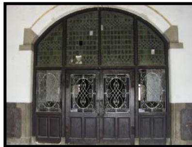
Gambar 2.8 : Detail pintu dengan kombinasi krepyak dan Glass in load
