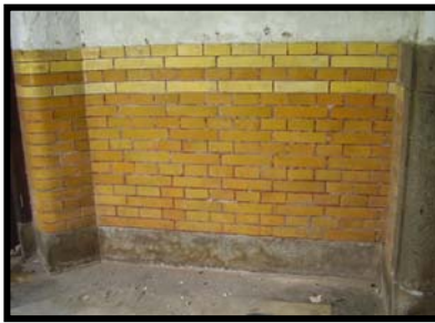
Gambar 2.7 : Detail dinding dengan bata ekspose
