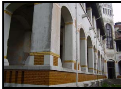
Gambar 2.7 : Detail dinding dengan bata ekspose
