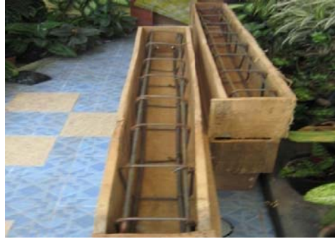
Gambar 4.24 Pembuatan Benda Uji Balok Sebelum Perbaikan
