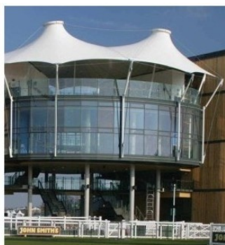
Gambar 63 : struktur kabel baja dan membran
