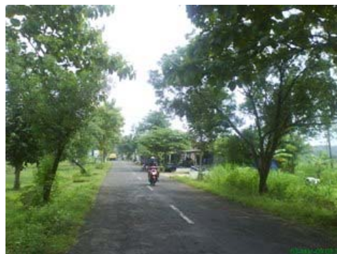
Gambar 47 : kondisi jalan utama, survey lapangan, 2009
