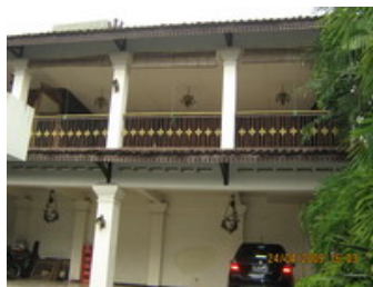
Gambar 97 : Eksterior Bangunan untuk Sanggar Tari Cakra Home Stay Kauman, Solo
