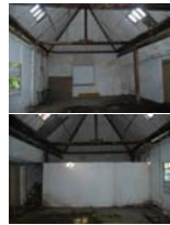
Keadaan Interior. Pada dasarnya menggunakan struktur konstruksi kayu umpak.
