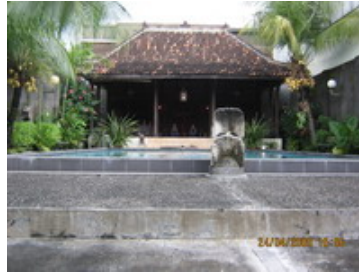
Gambar 94 : Eksterior Bangunan yang Dahulu Sebagai Tempat Proses Pembuatan Batik Cakra Home Stay Kauman, Solo
