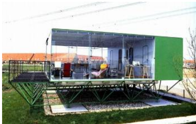
Gambar 4.3 Space-frame Sebagai Penyangga Lantai Pada Model Instant Glasshouse, Amsterdam Sumber : website Min-A-Max
