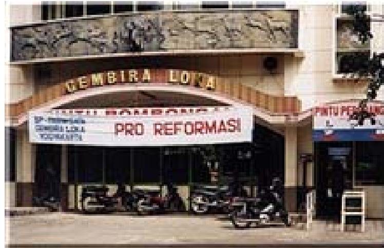
Gb. 2.15. Entrance kebun binatang Gembira Loka.
