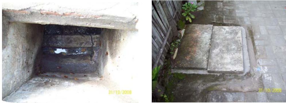
Gambar 4.13 Sambungan rumah dan bak kontrol
