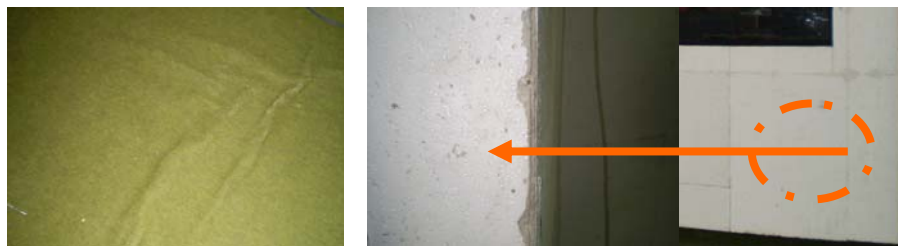
Gambar IV.2.1.3.4 lantai&dinding akustik Sumber: data pribadi
