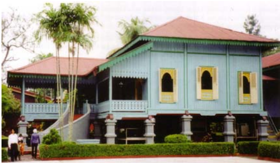
Gambar 2.10 Bangunan Beratap Limas Sumber : Rumah Melayu Memangku Adat Menjemput Zaman
