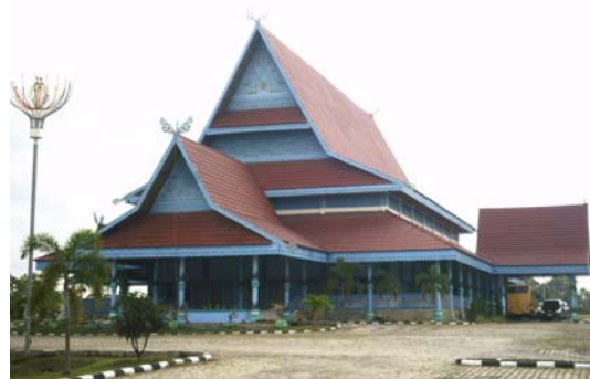
Gambar 2.8 Bangunan Beratap Layar Sumber : Survey
