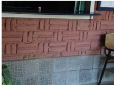
Gambar : bata ekspos Sumber : data pribadi, 2008
