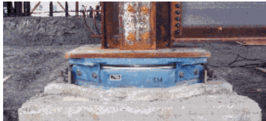
Gambar 4.10 Bantalan karet peredam getaran gempa (Sumber: Analisis Penulis)
