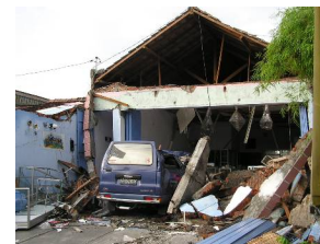
Gambar:2.9 a) Gambar 2.9 b) Kerusakan bangunan akibat gempa bumi ( Sumber: Google search, 2008 )
