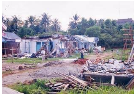
Gambar 1.3 Rumah rusak akibat Gempa bengkulu (Sumber: Google search, 2008)
