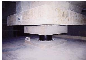
Gambar 2.11 Pondasi footplat dengan bantalan karet (Sumber: Google Search, 2008)
