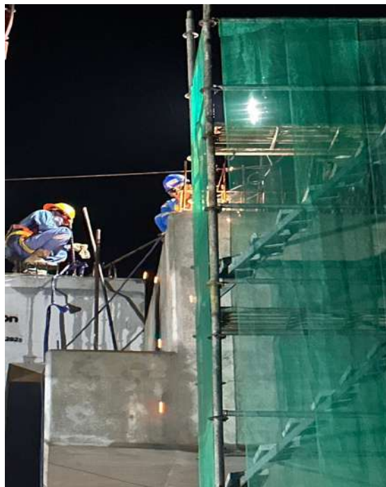
Lanjutan Gambar L-4 Pekerjaan Erection Girder
