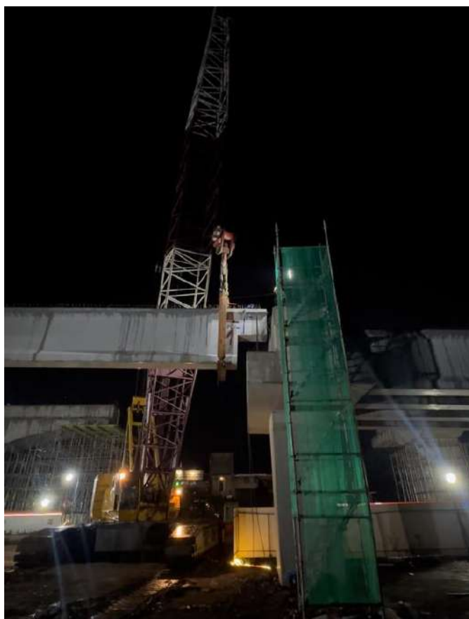
Lanjutan Gambar L-4 Pekerjaan Erection Girder
