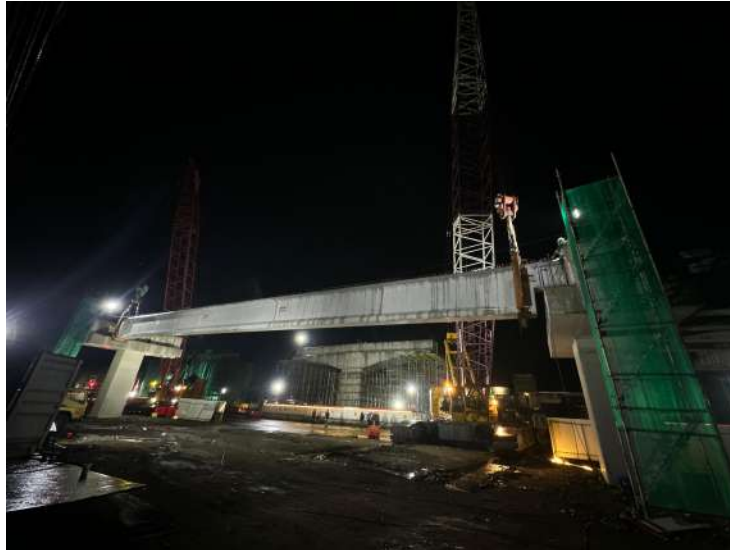
Gambar 5. 1 Pekerjaan Erection Girder (Sumber Pribadi)
