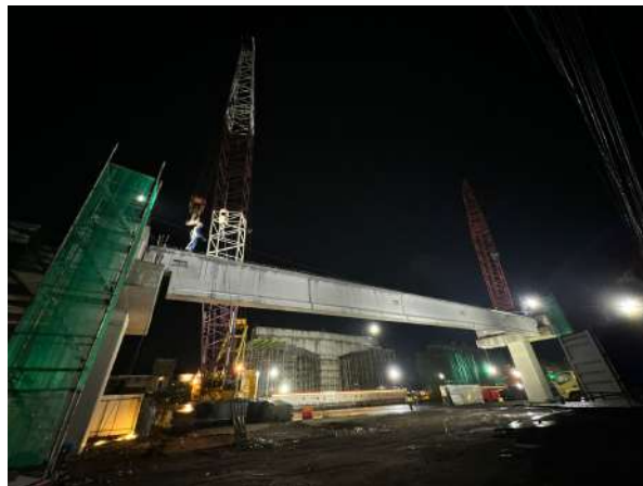
Gambar 1.1 Pekerjaan Erection Girder (Sumber Pribadi)
