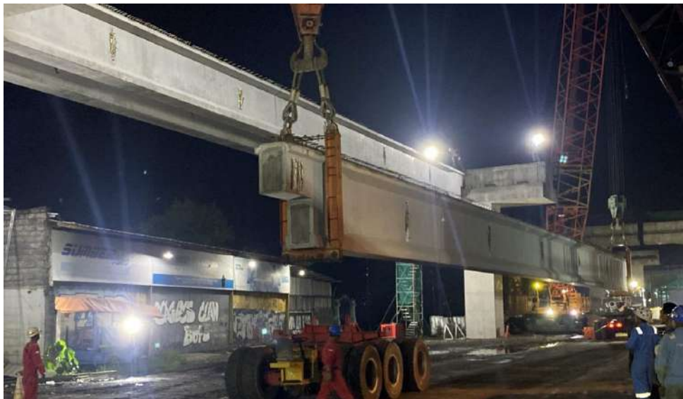
Gambar L-3 Pekerjaan Mobilisasi Girder
