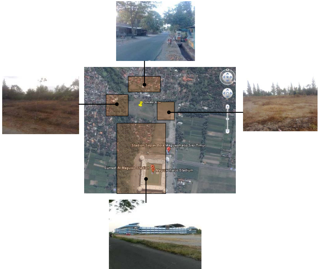
Gambar 4.7.3 : kondisi site dan foto survey Sumber : survey, november 2009
