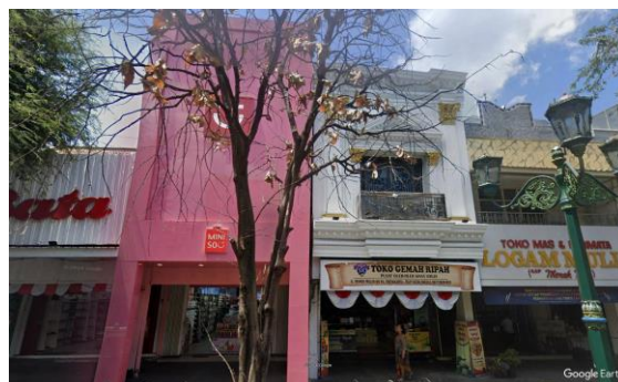
Gambar 4.17 Bangunan Toko Gemah Ripah gaya arsitektur Yunani-Romawi. Sumber: Google Street View, 2025
