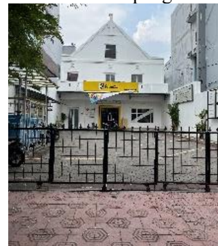
Gambar 4.6 Bangunan Baru Segmen Jalan Margo Utomo
