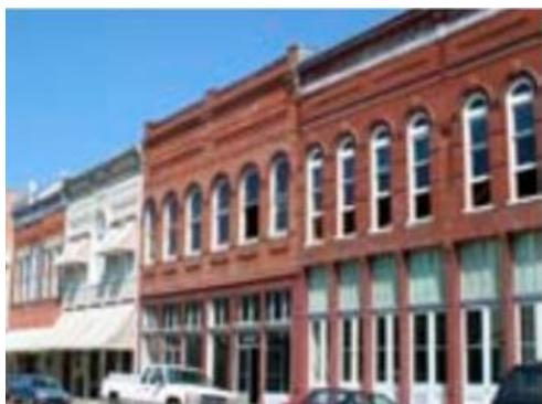
Gambar 2.4 Lantai dasar memiliki desain etalase dengan jendela besar dan pintu kaca. Sumber: (Barksdale, Johnson, and Matthews 2005)
