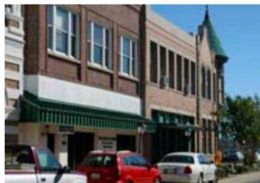
Gambar 2.5 Komposisi jendela yang sederhana dan bersifat individual pada lantai di atas lantai dasar, dengan proporsi vertikal serta menggunakan jendela tipe double-hung . Sumber: (Barksdale, Johnson, and Matthews 2005)
