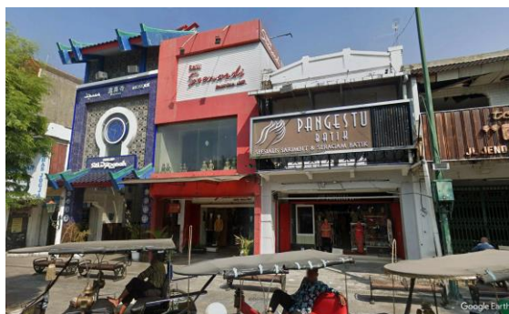
Gambar 4.16 Fasad Bangunan Batik Soewardi yang sangat Kontras Sumber: Google Street View, 2025
