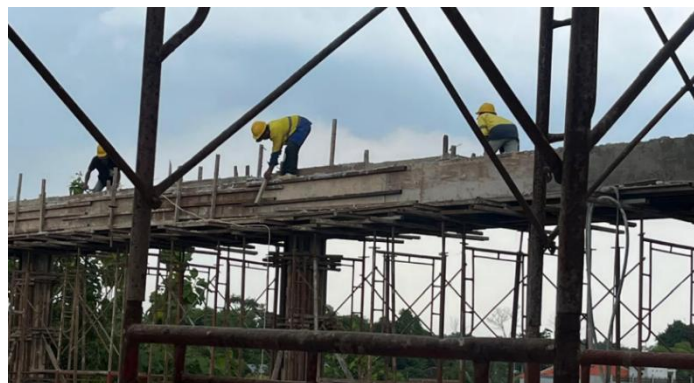
Gambar L-2.5 Proses Pembongkaran Bekisting Balok
