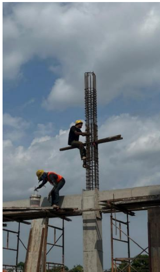
Gambar L-2.2 Proses Pembesian Kolom
