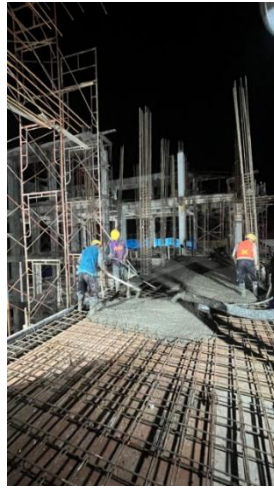
Gambar L-2.6 Proses Pengecoran Balok dan Pelat
