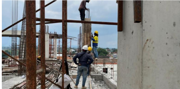
Gambar L-2.3 Proses Pemasangan Bekisting Kolom
