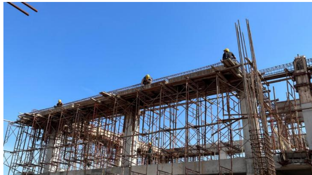
Gambar L-2.4 Proses Pembesian Pelat
