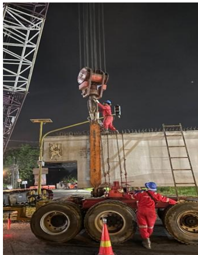
Gambar L-3.3 Pengaitan Titik Angkat Girder ke Crane
