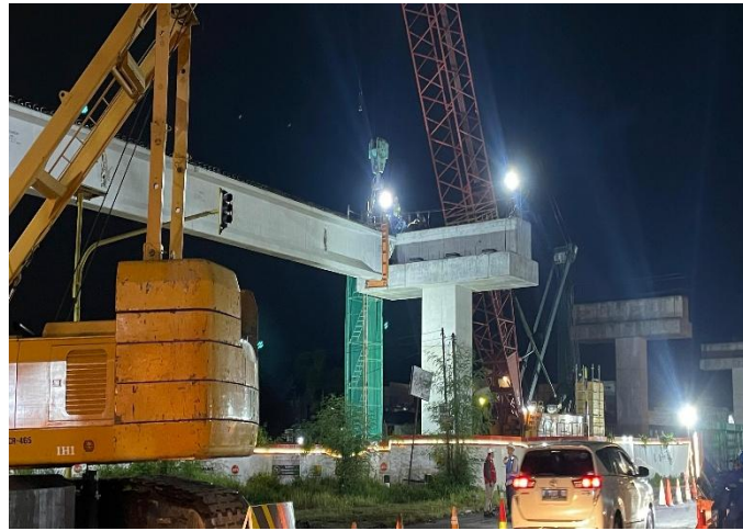
Gambar L-3.5 Proses Penurunan Girder ke Pilar
