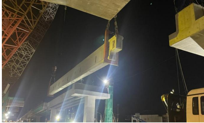
Gambar L-3.4 Proses Pengangkatan Girder
