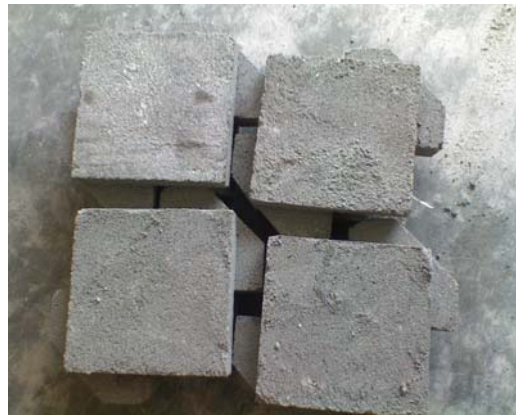
Pemasangan Batako Berkait
