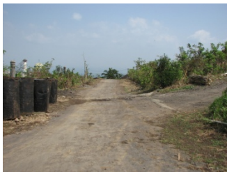
1. Kondisi jalan didepan site
