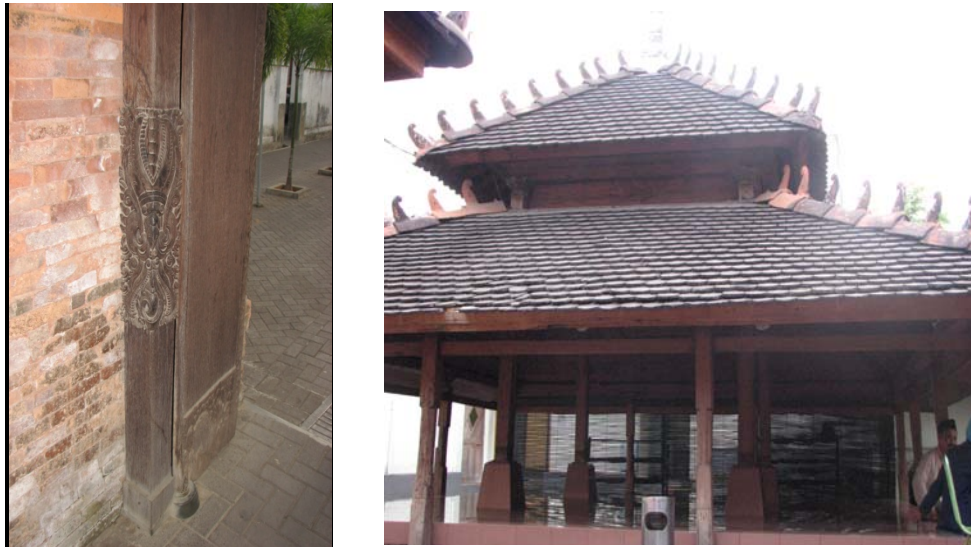
Gambar 2.6. Bentuk atap dan ukiran pintu Menara Kudus
