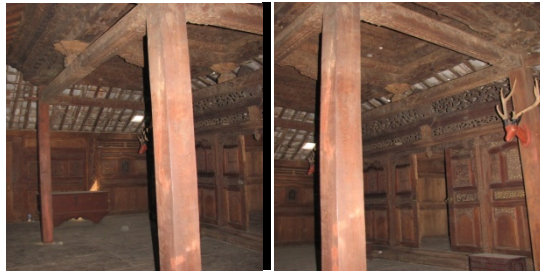
Gambar 2.1. Struktur utama Rumah Adat Kudus
