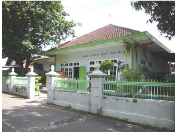
Gambar 2.1 Bangunan IVAA bagian depan Sumber: Dokumen pribadi
