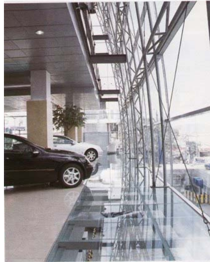
Gambar 3.11 Struktur kerangka baja mengimbangi lengkungan kaca Sumber : Griya Asri
