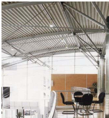
Gambar 3.12 Struktur kerangka baja mendukung atap lengkung Sumber : Griya Asri
