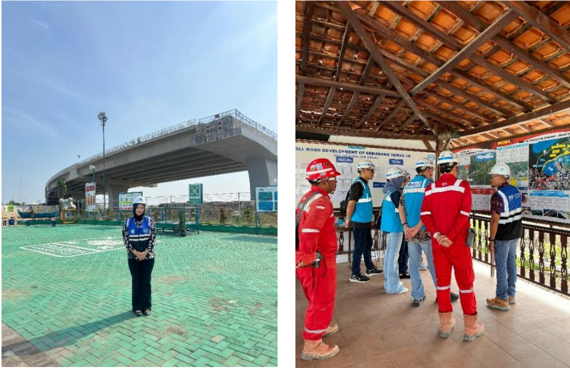
Gambar 1 Kegiatan Site Visit Proyek Jalan Tol Seksi 1 (Tahap Konstruksi)
