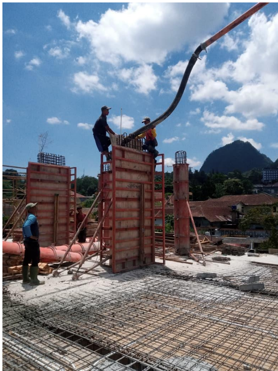
Gambar L-4.4 Proses Pekerjaan Pengecoran
