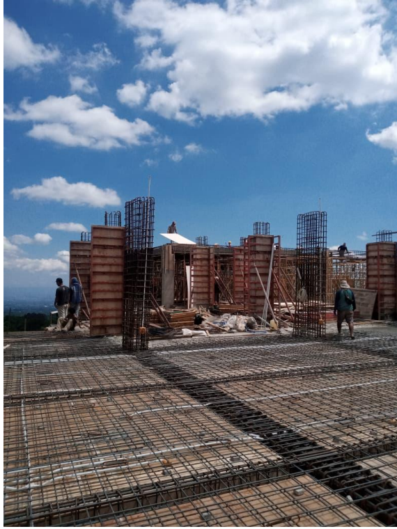
Gambar L-4.3 Proses Pekerjaan Pemasangan Bekisting
