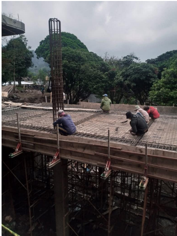
Gambar L-4.2 Proses Pekerjaan Pembesian
