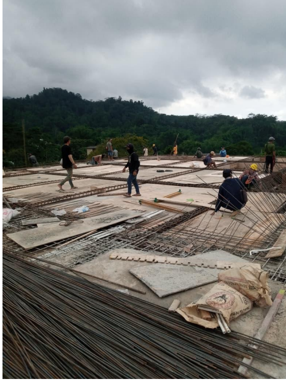
Gambar L-4.1 Proses Pekerjaan Pemasangan Bekisting
