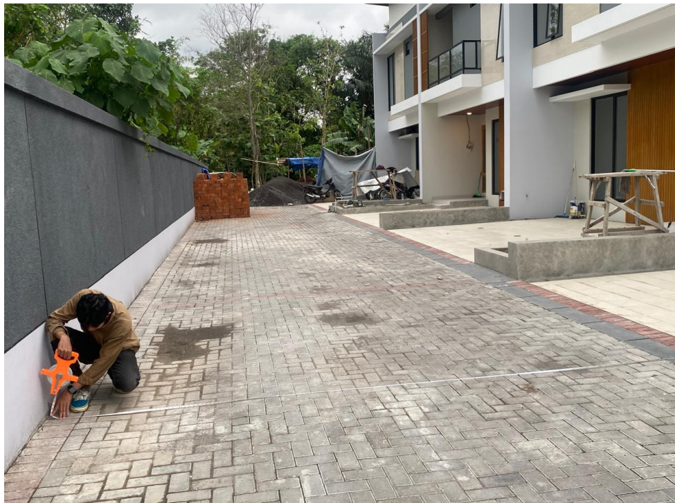
Gambar 5.10 Jalan Lingkungan Perumahan (Sumber: Dokumentasi Pribadi, 2025)
