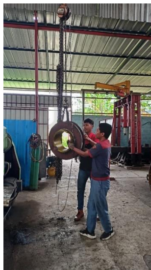
Gambar 4. 3 Pemindahan bahan dari mesin ke mesin dengan hoist crane
