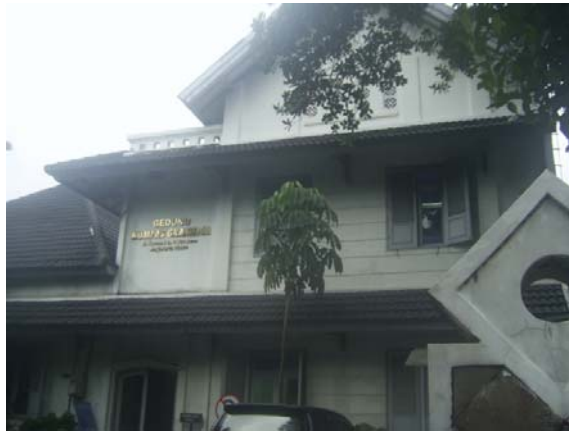
Gbr 4.26 bangunan colonial di kridosono Sumber : Survey
