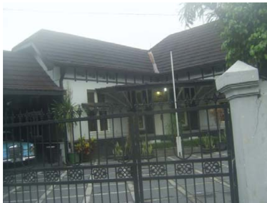
Gbr 4.24 bangunan colonial di kridosono Sumber : Survey
