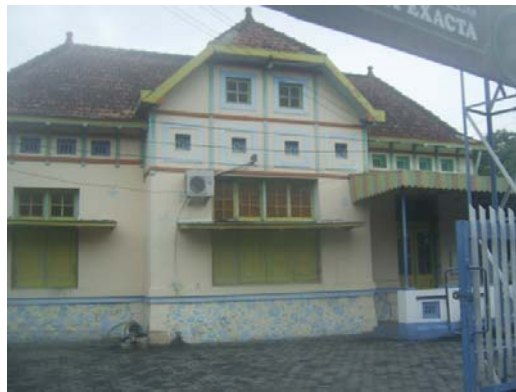
Gbr 4.22 bangunan colonial di kridosono Sumber : Survey
